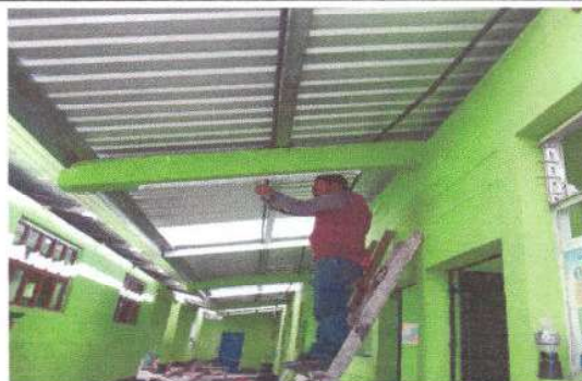
Foto 4: Sustitucion del Sistema Electrico
