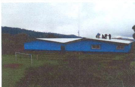
Foto1: Cambio de Techo por Lamina Troquela Aluzinc Calibre 26
