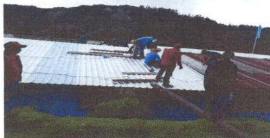
Foto 2: Cambio de Techo por Lamina Troquela Aluzinc Calibre 26
