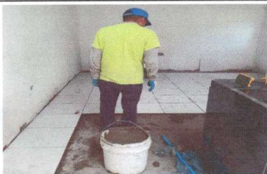
Foto 3: Sustitucion de Piso Ceramico
